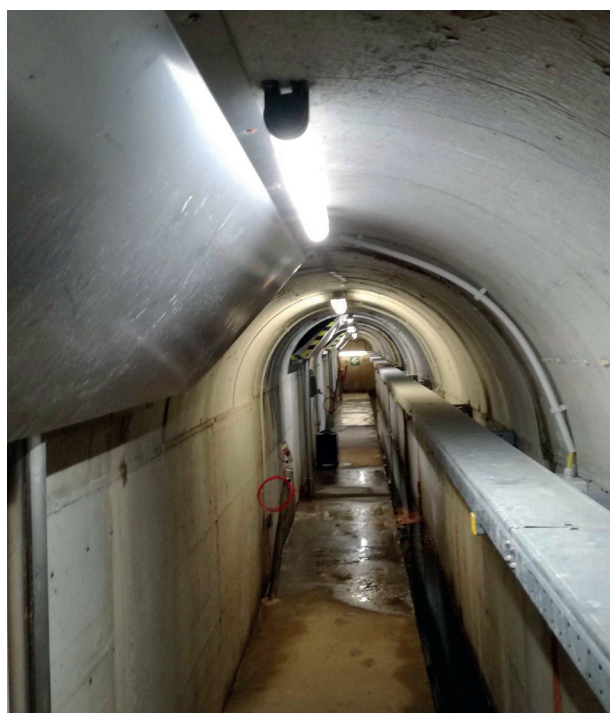
Illuminazione cunicoli e tunnel
