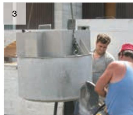
Il tubo in calcestruzzo con la costruzione in acciaio inox viene preparato per l'inserimento. Realizzare il foro per l'alimentazione.
