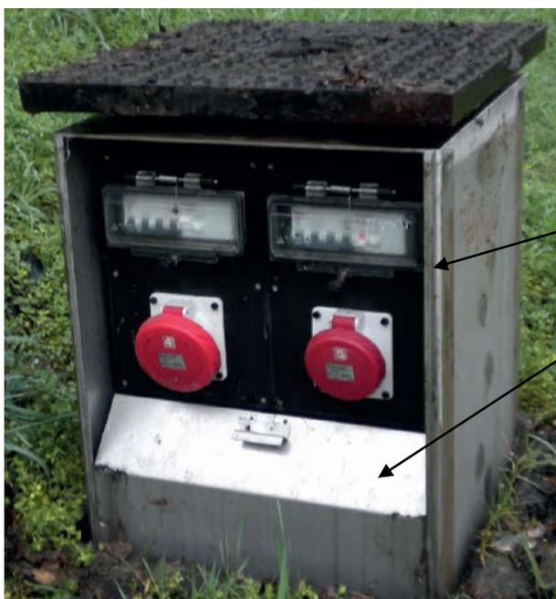
Struttura in acciaio AISI 304
