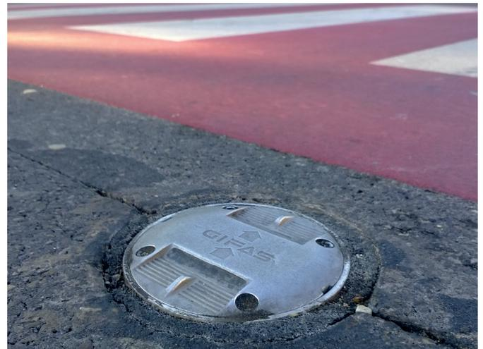
Il TrafficLED è un sistema certificato EMC, per questo funziona tramite cablaggio e non induttivamente, motivo per cui sono escluse interferenze elettromagnetiche.
