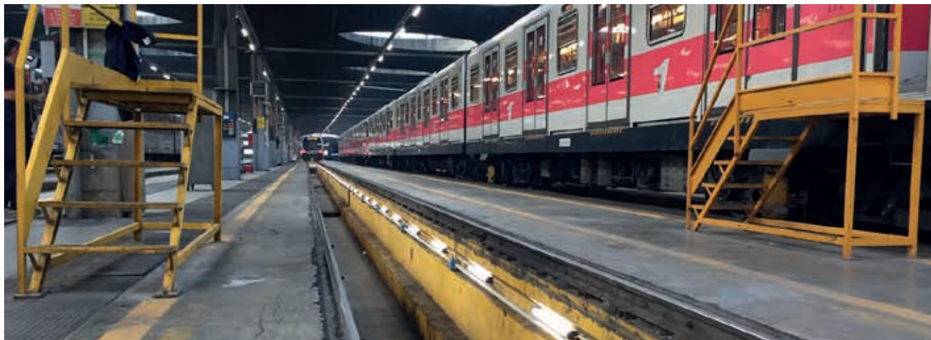
Illuminazione fosse ferroviarie
